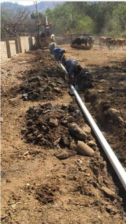
**VARIAS IMÁGENES DE LAS DIFERENTES ACTIVIDADES ANERIORMENTE MENCIONADAS, AQUÍ EL MANTENIMIENTO DE TUBERÍAS Y SOLUCIÓN DE DETALLES DE DRENAJE.**
